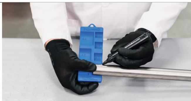
Рис. 28. Маркировка глубины вставки.
