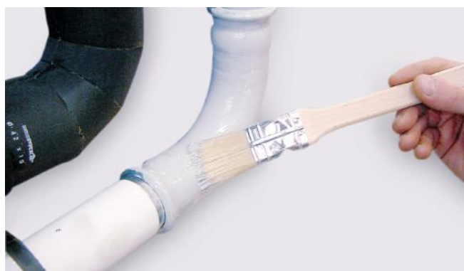
Рис. 37. Покраска соединений и труб праймером.
