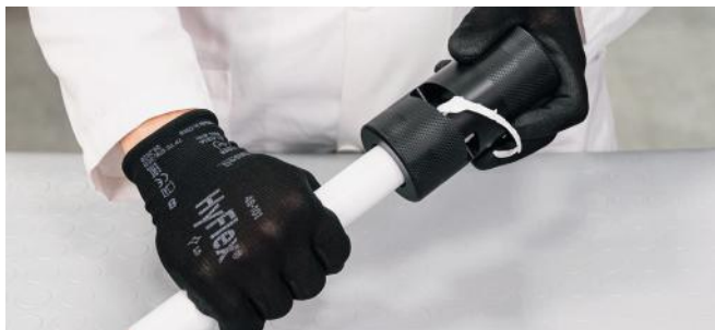
Рис. 29. Резка (труба steelPRES в изоляции из полипропилена).
